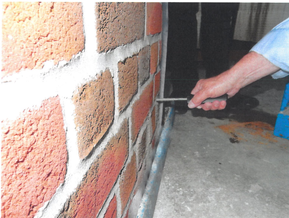
Bild 2 Reinigung der Bohrlöcher
