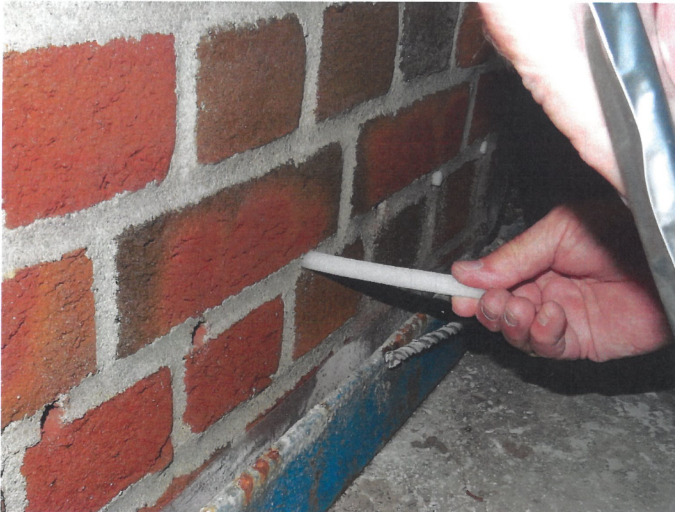
Bild 3 Einschieben der Secco Horizontalsperren-Sticks
