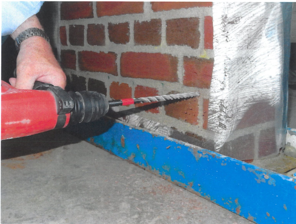
Bild 1 Anlegen der Bohrungen
