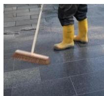
Mörtelreste mit einem weichen Besen und leichtem Wasserstrahl vollständig von der Belagsoberfläche entfernen.
