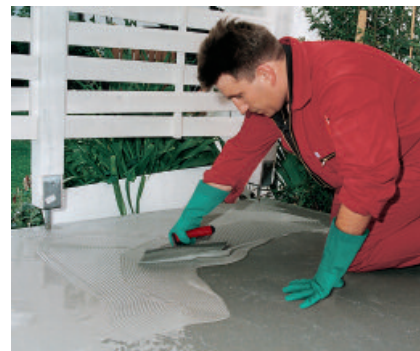
Die PCI Seccoral-1K-Abdichtung kann an Wand und Boden gestrichen oder gespachtelt werden.
