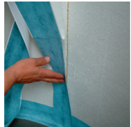
Schutzfolie abziehen und PCI Pecitape WS ohne Vorspannung mit kräftigem Druck aufkleben – fertig!
