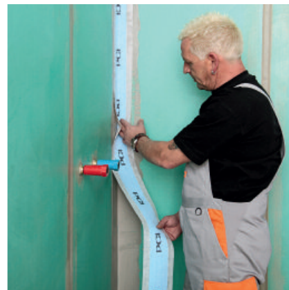
PCI Pecitape wird in die frische Auftragsschicht des verwendeten Abdichtungsmaterials eingebettet.
