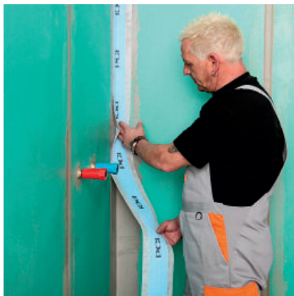
2b. Eck- und Anschlussfugen abdichten. Nachfolgend das Dichtband PCI Pectape mit leichtem Druck in das noch frische PCI Lastogum einbetten.
