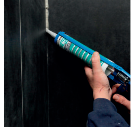
6. Eck-, Anschluss- und Bewegungsfugen elastisch schließen.
