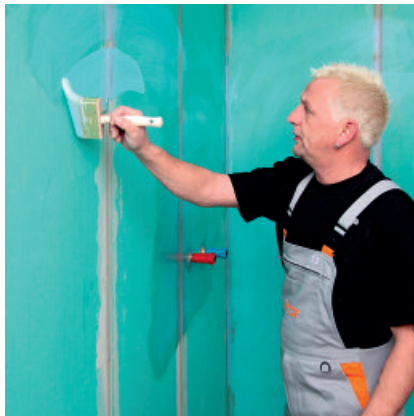
1. Grundierung PCI Gisogrund flächendeckend auftragen.
