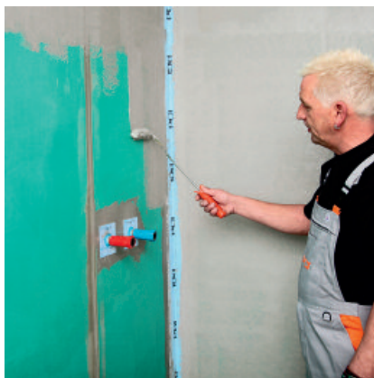
3. PCI Lastogum® in zwei Arbeitsgängen dann flächendeckend auftragen.
