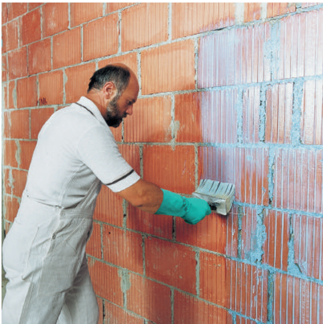
PCI Gisogrund verbessert die Haftung von Gips- und Kalkgipsputzen an Ziegelmauerwerk.
