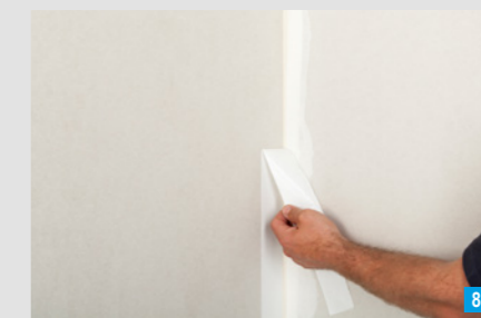
Überstehenden Streifen abziehen
