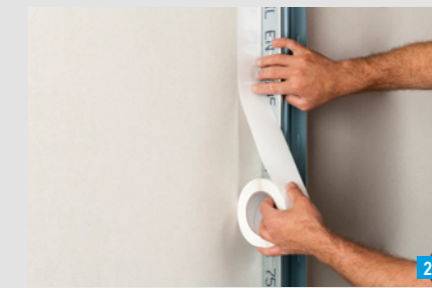
Trenn-Fix neben Profil kleben
