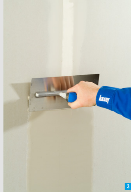
Überspachteln des Fugendeckstreifens mit gebogener Traufel
