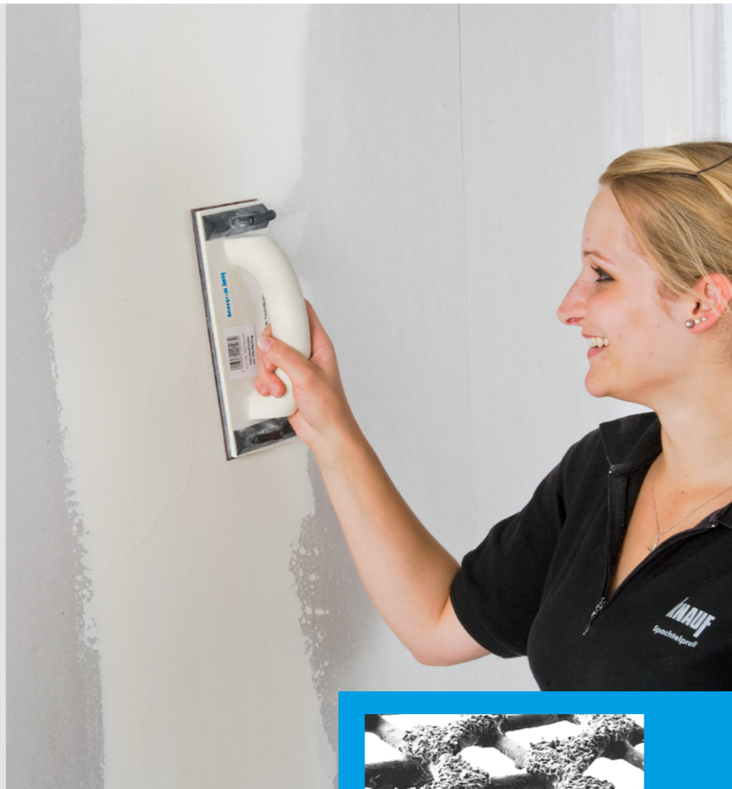
Knauf Abranet® Handschleifer mit Absaugung
