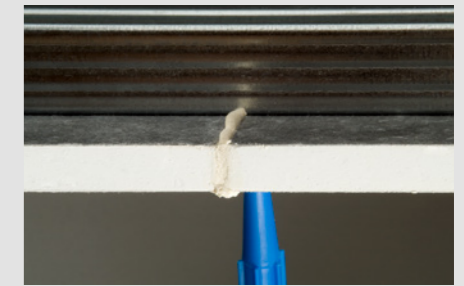
Seitenansicht beim Füllen der Fuge mit Knauf Uniflott
