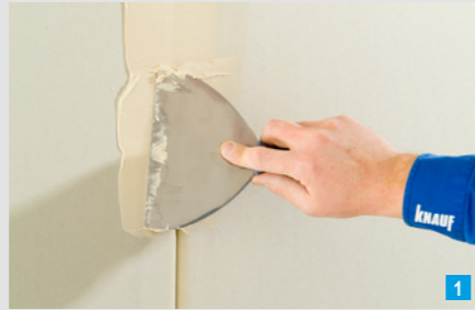
Eindrücken der Spachtelmasse quer zur Fuge
