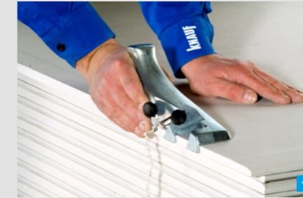
Anfasen einer SFK mit dem Kantenhobel
