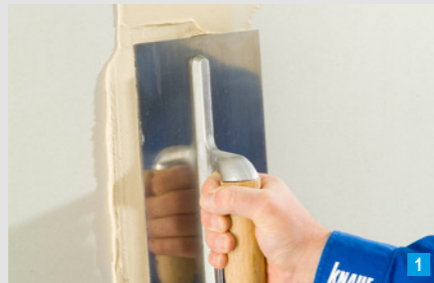
Eindrücken der Spachtelmasse quer zur Fuge
