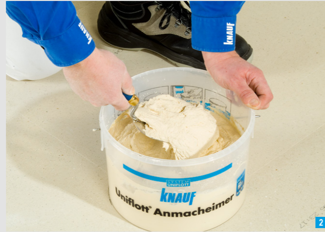
Anrühren von Knauf Uniflott mit der Kelle
