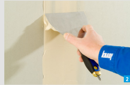
Abziehen in Längsrichtung
