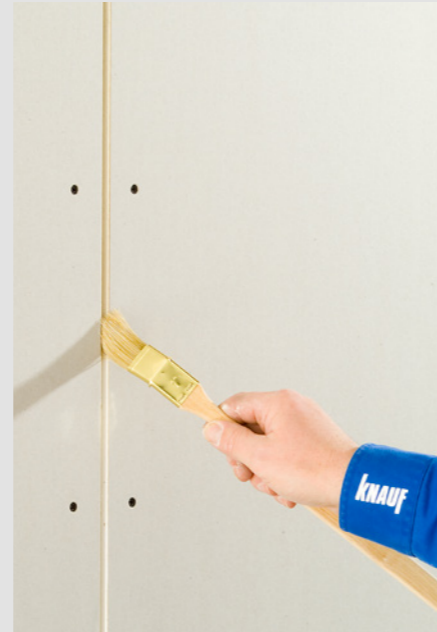
Aufbringen von Knauf Tiefengrund
