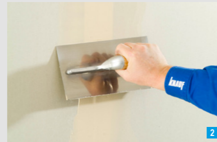
Abziehen in Längsrichtung
