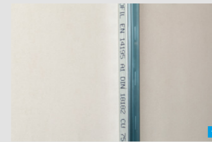
Profil auf angrenzendes Bauteil montieren
