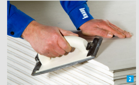
Brechen mit dem Handschleifer bei Knauf Cleaneo-Platten
