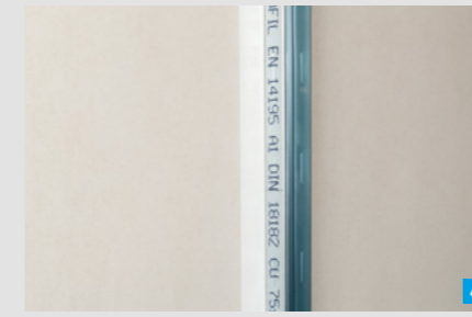
Trenn-Fix andrücken und glatt streichen
