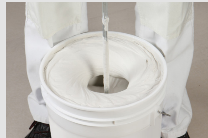
Auführen von Knauf Superfinish mit dem Quirl.
