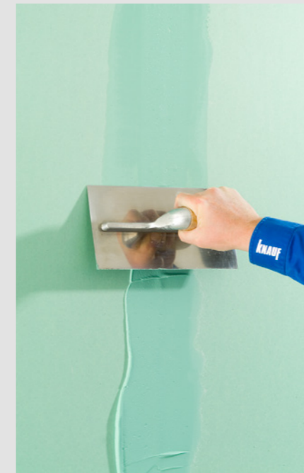
Knauf Uniflott imprägniert für imprägnierte (grüne) Gipsplatten
