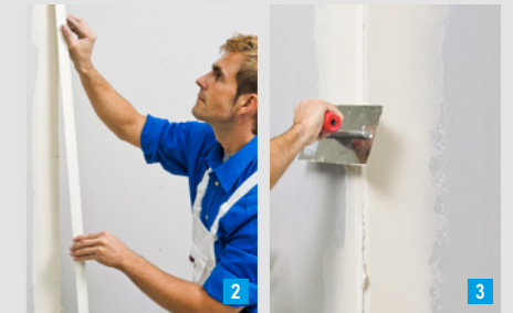
... und einlegen, anschließend überspachteln
