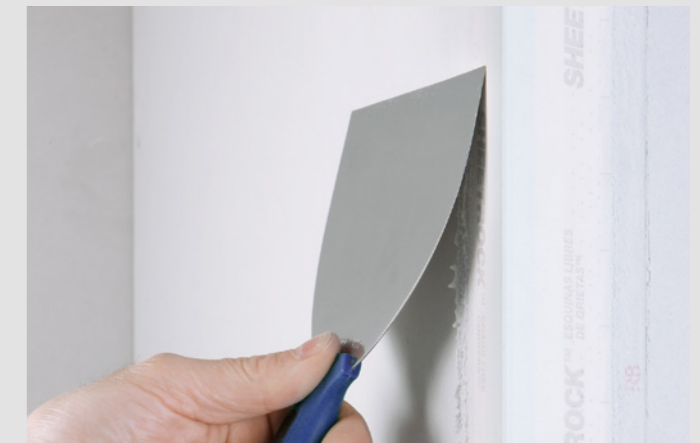
Nach dem Auführen ist Knauf Superfinish verarbeitungsfertig.
