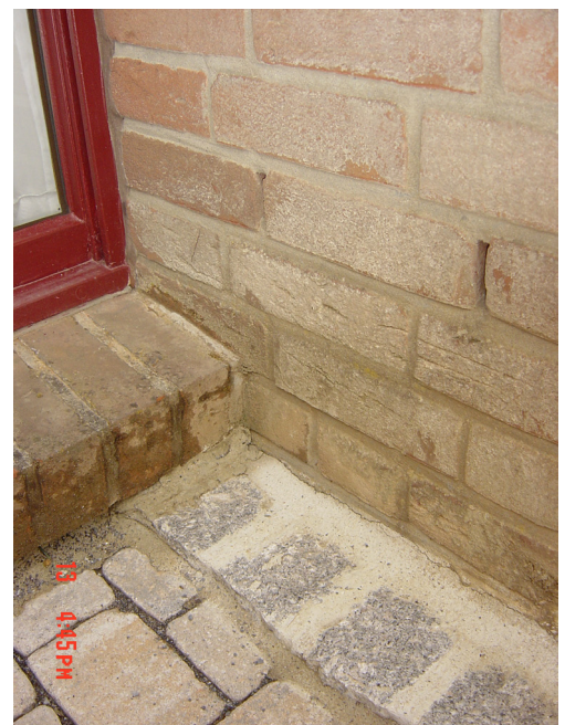
Das Sichtmauerwerk nach LotuClean A-Reinigung
