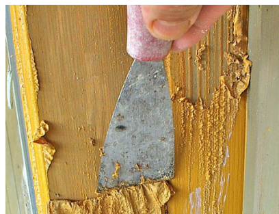
„Malerlack“ nach 20 Minuten mit einem Tuch entfernbar
