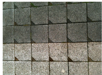
Gehwegpflaster, oben: verschmutzt, unten: mit LotuClean SF gereinigt (Einwirkungszeit 15 Minuten und nachgespült).
