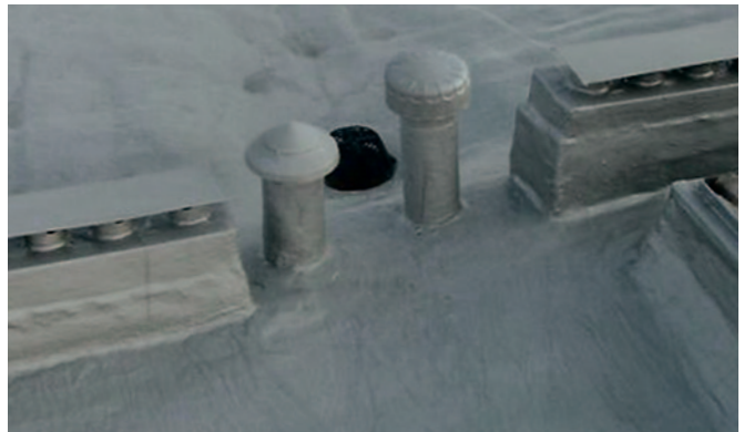
Dachdurchdringungen unterschiedlicher Art
