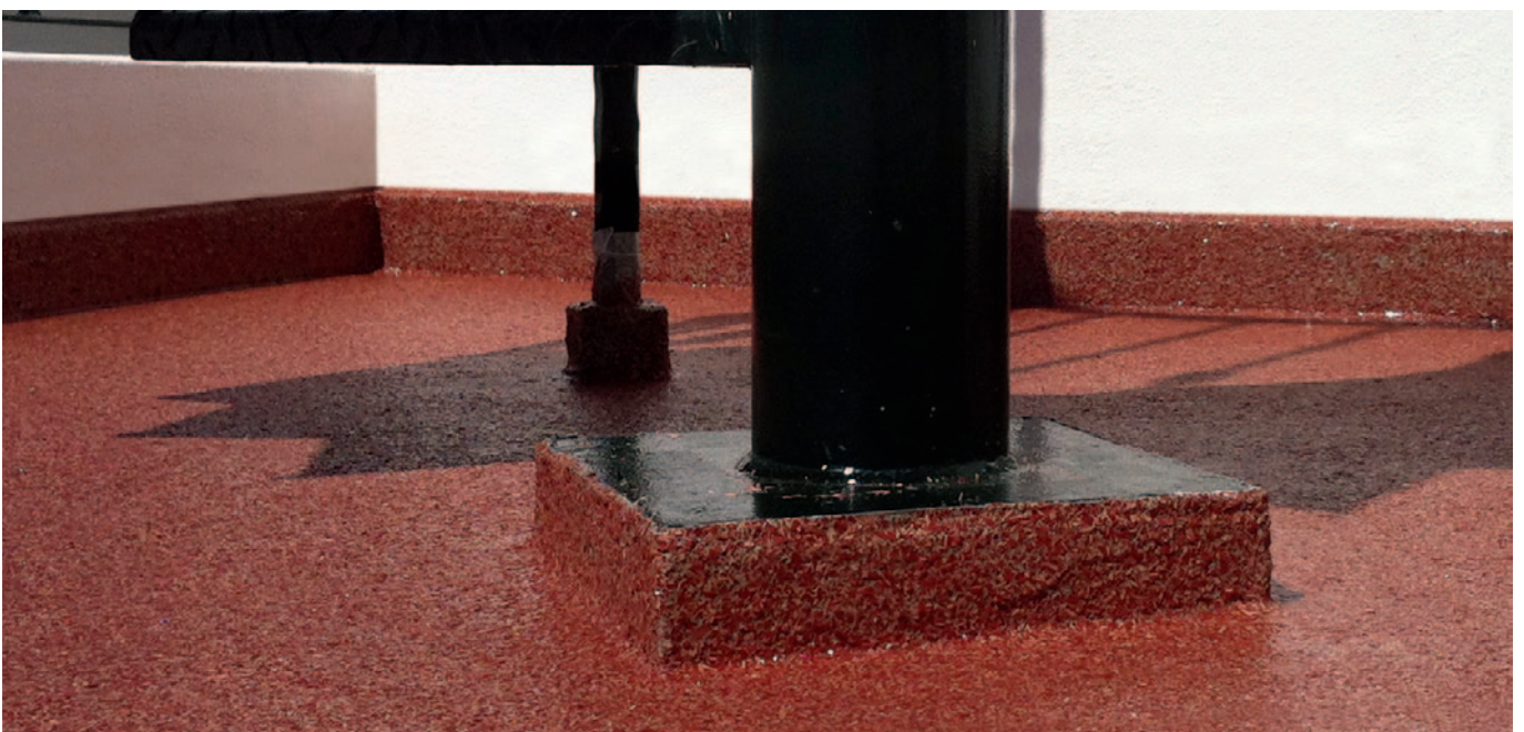
Detail- und Wandanschlüsse
