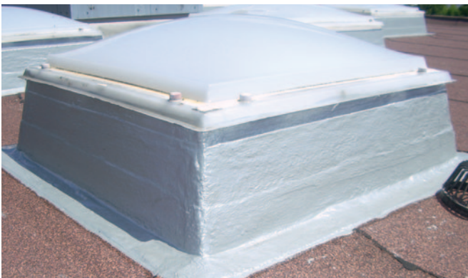
Abdichtung von Lichtkuppeln
