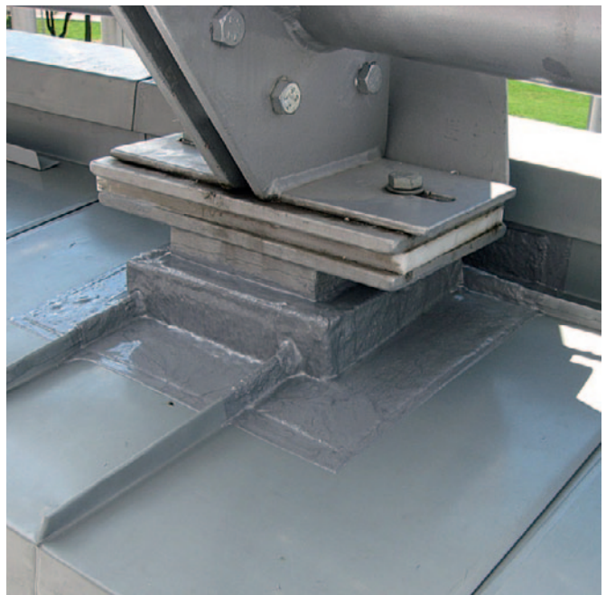
Dachaufbauten mit komplizierter Geometrie
