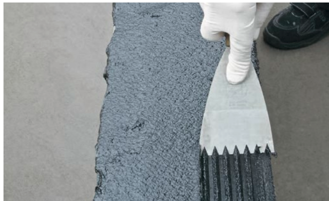
Enkolit® mit dem Rillenspachtel abziehen
