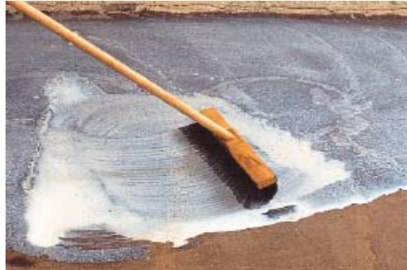
Industriebodenbeschichtungen ist grundsätzlich eine mechanische Untergrundvorbereitung erforderlich (z. B. Schleifen / Strahlen/ Fräsen/ Absaugen). Die Verfahren Kugelstrahlen oder Fräsen und Kugelstrahlen sind nach DAfStb-Richtlinie, Ausgabe Oktober 2001, Teil 2, Tabelle 2.5 auszuführen.
