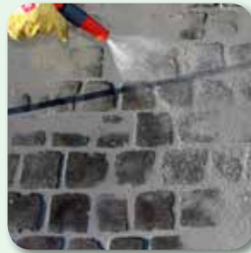
diagonal zur Fuge abreinigen
