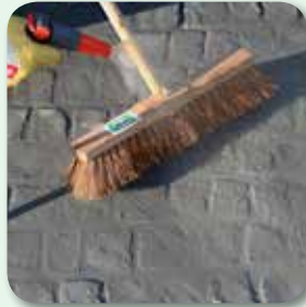
Erhärten des Mörtels auf der Oberfläche vermeiden
