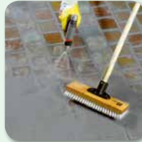
diagonal zur Fuge abreinigen
